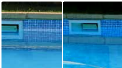
Povrch vně plaveckého bazénu
